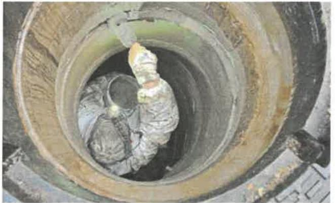
Mit der Sanierung von undichten Schächten und Kanälen wurde bereits begonnen.
