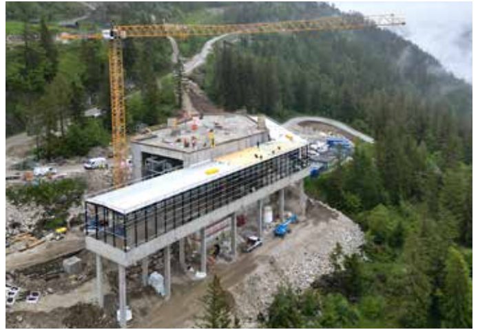
Baufortschritt an der Zwischenstation.
