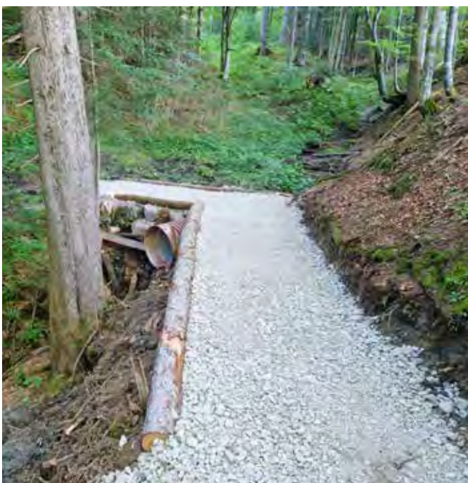
Sanierter Weg im Bereich der Habersamerin.
