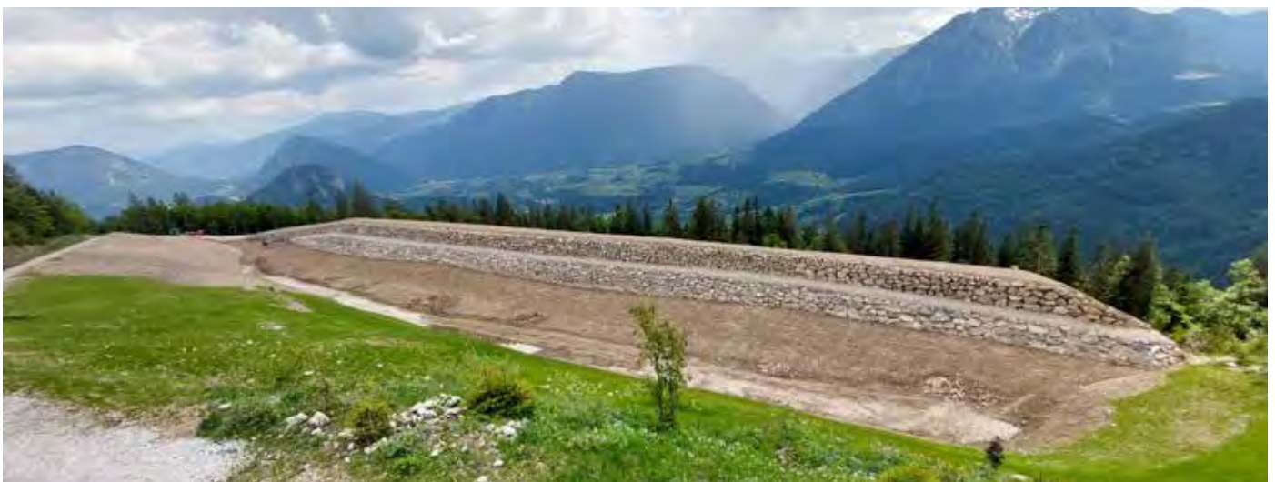
Lawinenauffangdamm bei der Donalawine
