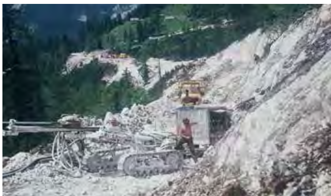
Bauabschnitt unterhalb der Loserstraße.
