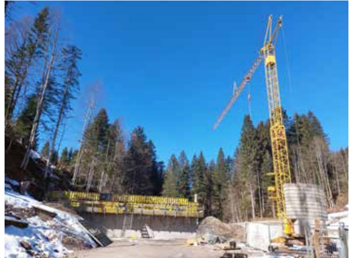
Bauarbeiten der Geschiebesperre im Bereich Losermaut.
