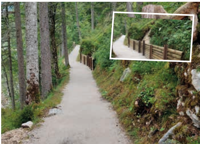
Wegsanierung und Stützkonstruktion im Bereich Lechtstein.
